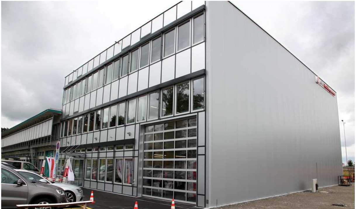
Der neue Erweiterungsbau des Ausbildungszentrums an der Lerchentalstrasse in St.Gallen
